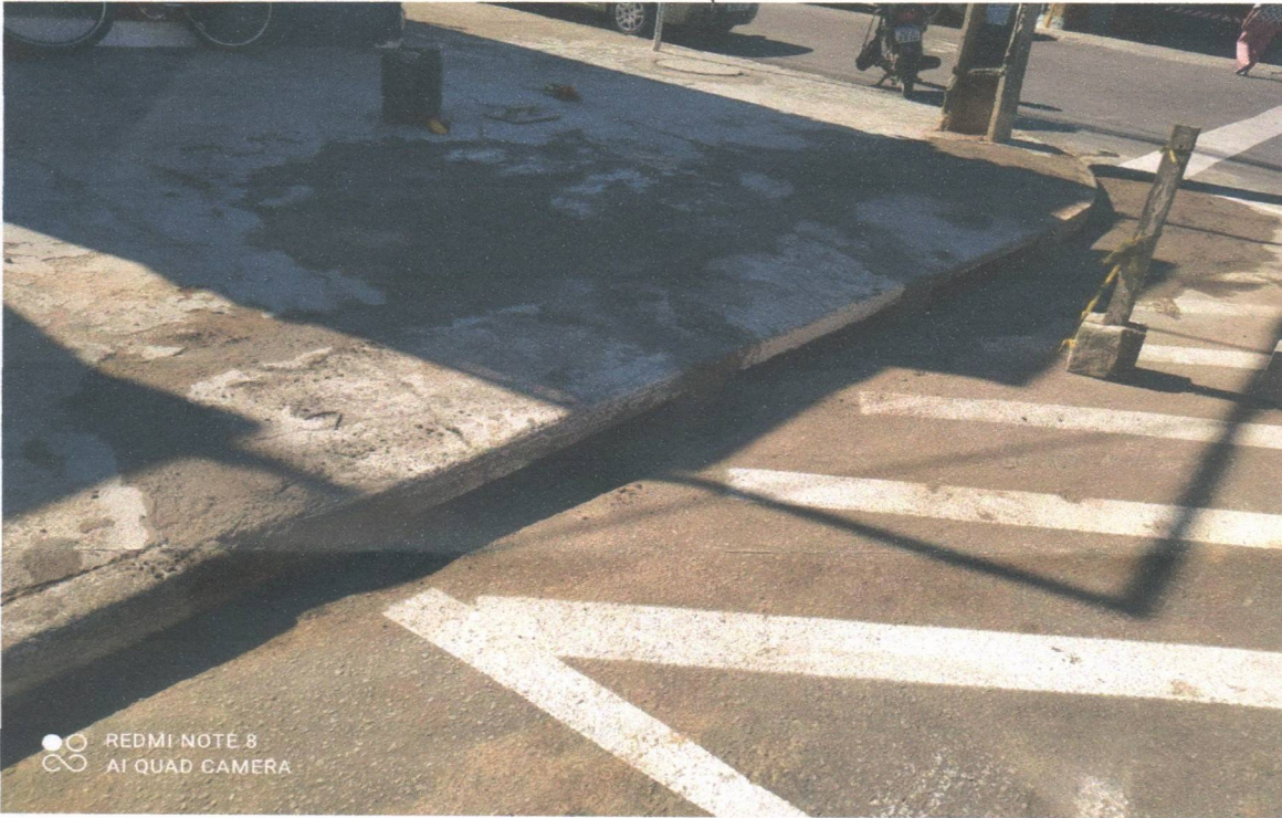
Avenida Itabuna c/Av. Piauí – 01/02/2024
