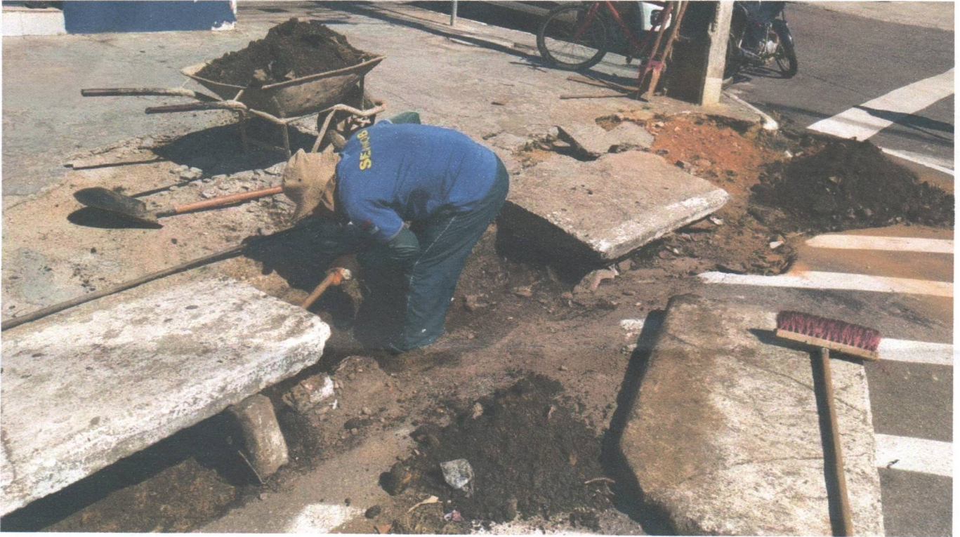
Avenida Itabuna c/Av. Piauí – 01/02/2024
