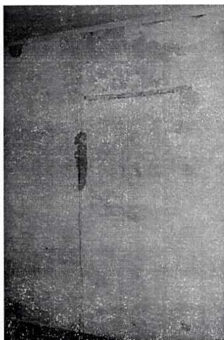
Foto 6: umidade e fissura
